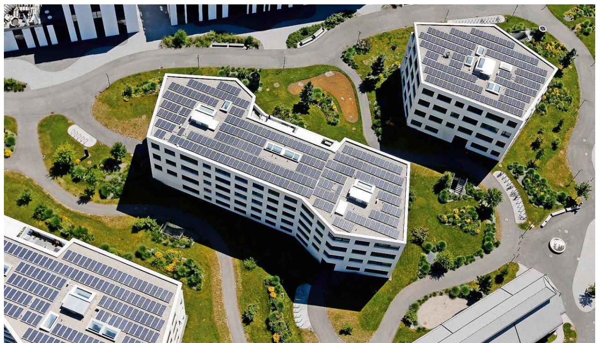
Blick von oben auf das Suurstoffi-Areal in Risch-Rotkreuz mit seinen Solaranlagen.
