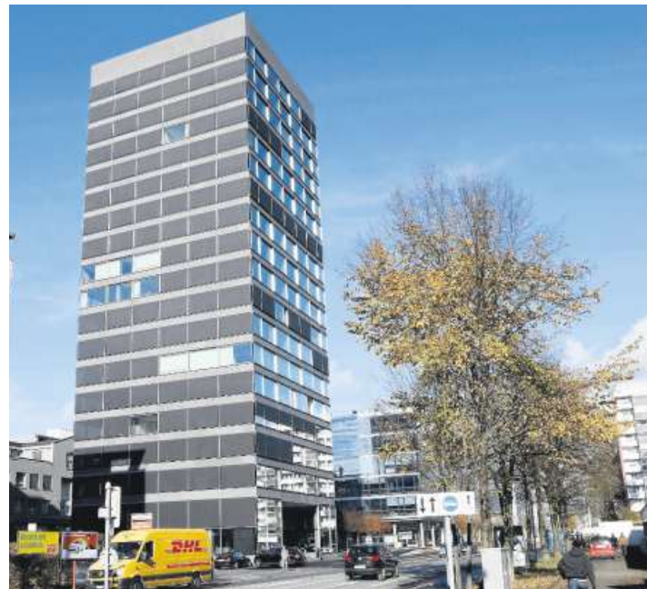
Hochhaus B125 in Zug. Bild: Werner Schelbert (19. November 2014)
