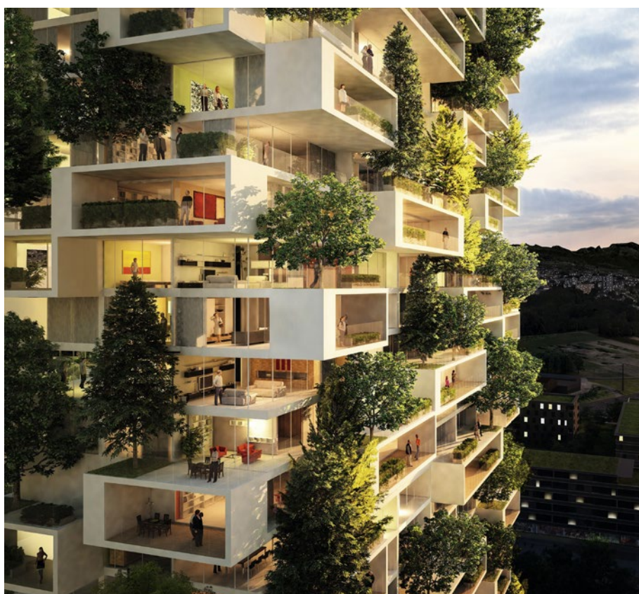
Ein Zedernwald in der Vertikalen – so präsentiert sich dereinst das Hochhaus «Tour de Cèdres» bei Lausanne (Bilder oben).
