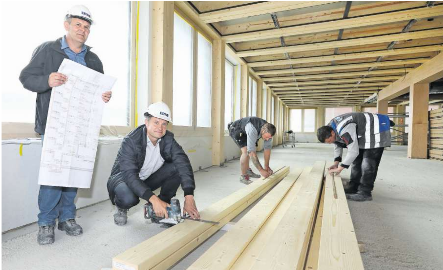
500 Kubikmeter Holz werden im Hochhaus verbaut. Fast alle Elemente konnten im Werk vorgefertigt werden. Die Bauleiter Peter Dörfinger (von links) und Marc Kanzenbach inmitten der Baustelle in der Suurstoffi 22 in Rotkreuz.
