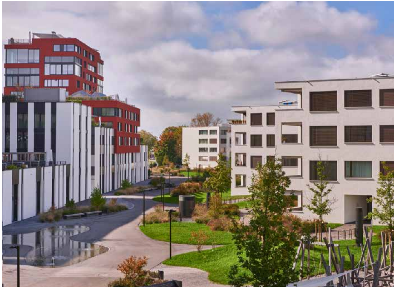
Ein Pilot- und Demonstrationsprojekt des Bundesamts für Energie: Das Anergienetz des Suurstoffi-Areals in Rotkreuz verbindet Büro- und Wohngebäude für 2500 Arbeitsplätze und 1500 Bewohner.
