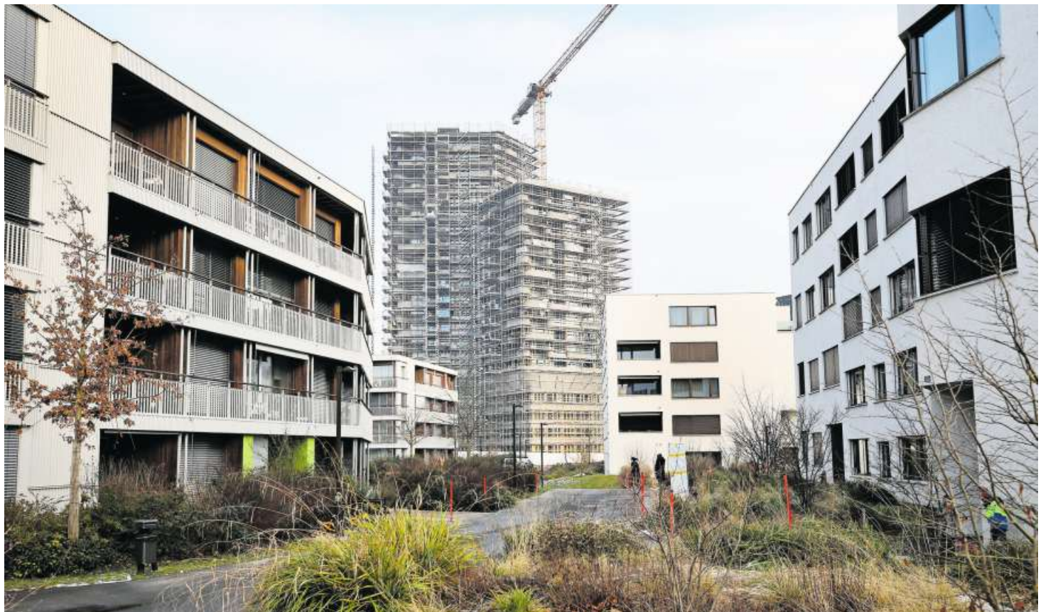
Die Bauarbeiten für «Aglaya» laufen auf Hochtouren. Ab November erfolgt der Bezug.
