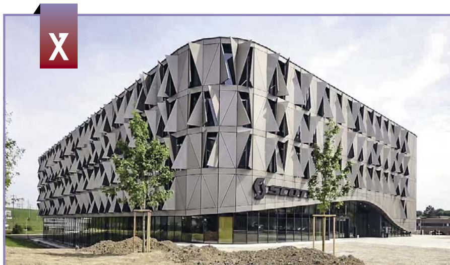
Die perforierten Alu-Fassadenelemente reagieren automatisch auf Wind und Sonne und sorgen auch im geschlossenen Zustand für ausreichend Licht im Innenbereich. (Video: Zinniker)
